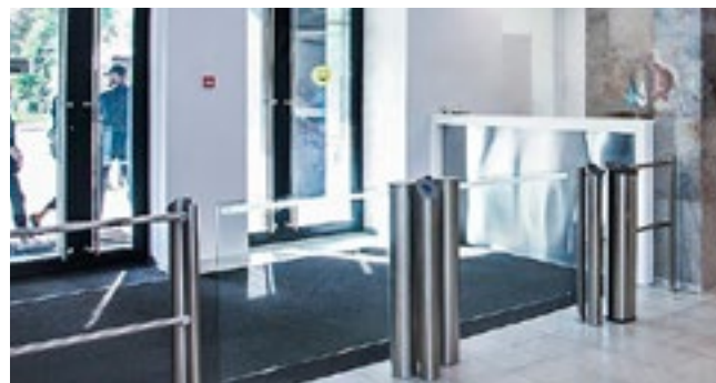
Бизнес-центр «Дубровка», Москва
