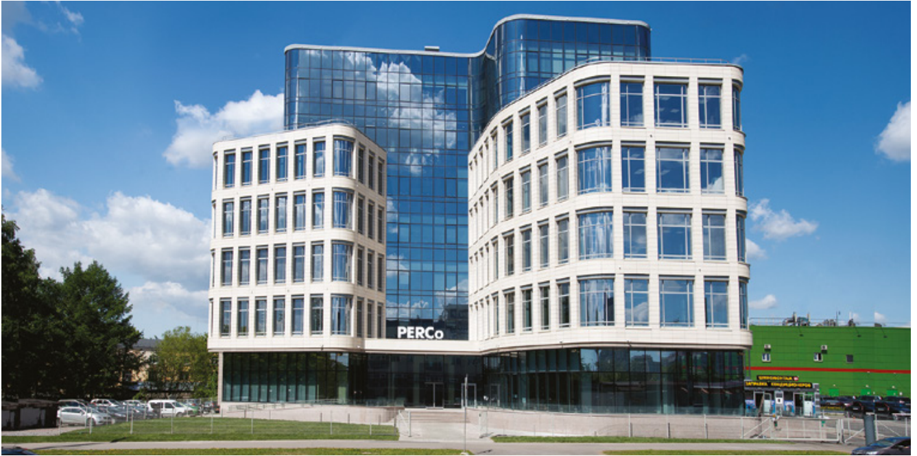
Главный офис PERCo
